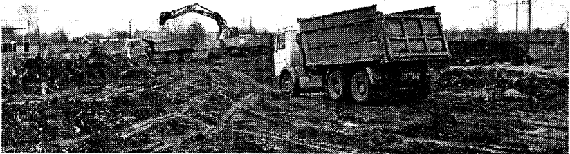
Земляные работы на участке под приют ведутся уже с прошлой среды
